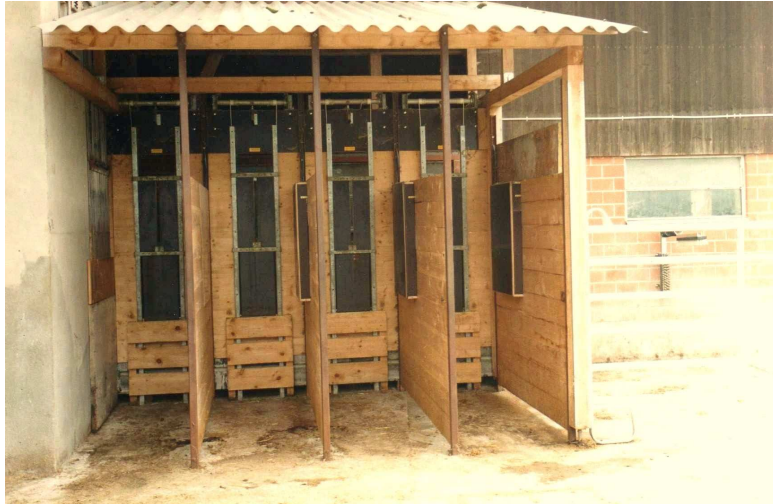
Fress-Standanbau für 4 Pferde mit automatischen Raufutterklappen am Kopf des jeweiligen Fress-Standes.
